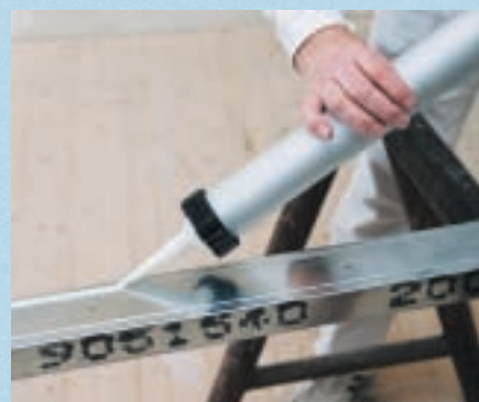
Knauf Trennwandkitt az UWV profil hátoldalán
